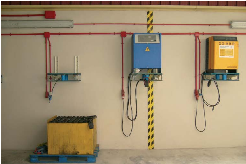
ZONA DE CARGA DE BATERÍAS
